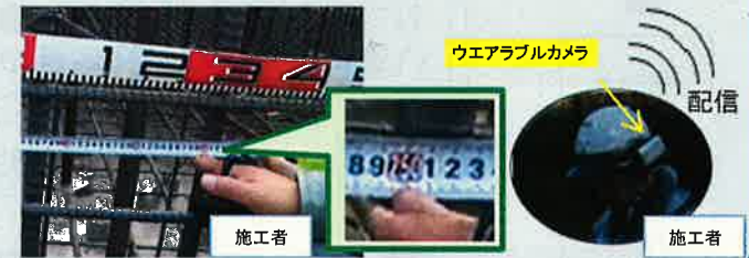
施工者が出来形を撮影し監督職員へ配信
