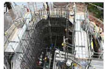
新技術により打設回数を減らした施工事例 →コールドジョイントを予防 出典)北海道開発局
