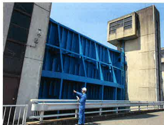
目視による臨時点検 (水門)
