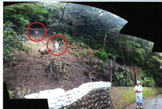
危険な斜面での調査作業
