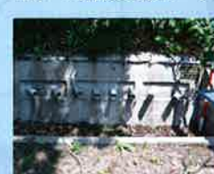
地すべり対策の横ボーリング工の実施状況
