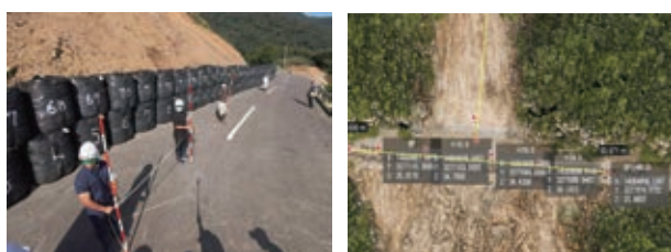
写真3 随行者による計測(左)とタブレットによる計測(右)
