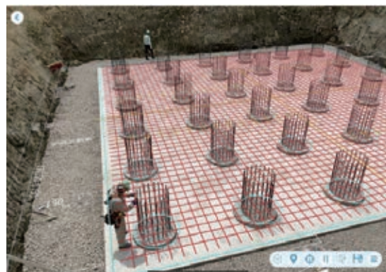
図16 配筋位置の重ね合わせ
