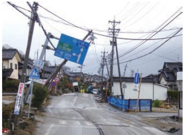
写真2 被災状況（内灘町における液状化）
