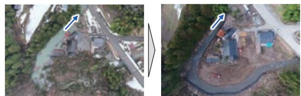
写真4 河道埋塞土砂の除去（能登町 山田川）
