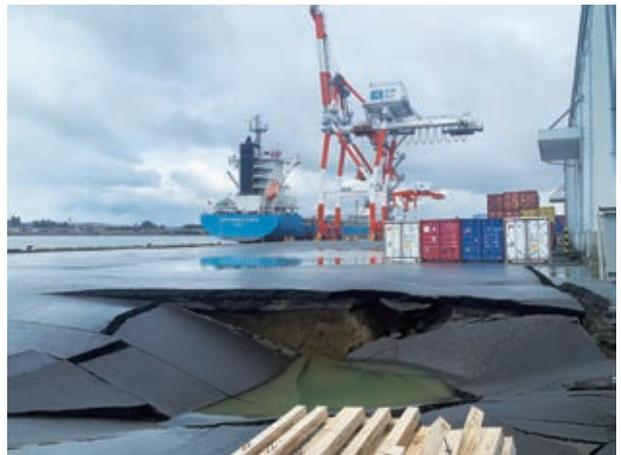
写真9 液状化による舗装陥没（金沢港）
