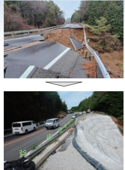
写真3 のと里山海道の応急復旧状況
